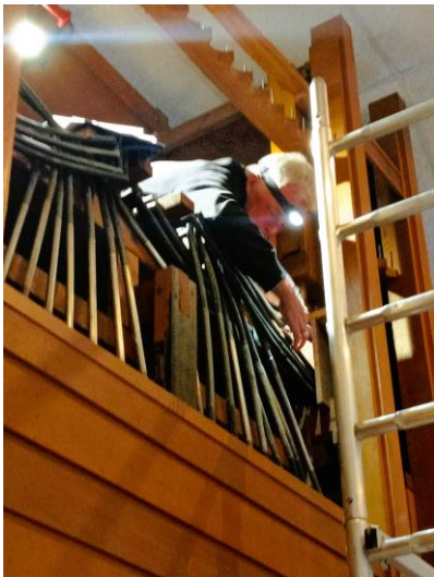
De orgelbouwer bezig met het positioneren en verlijmen van de verbindingsbuizen.
